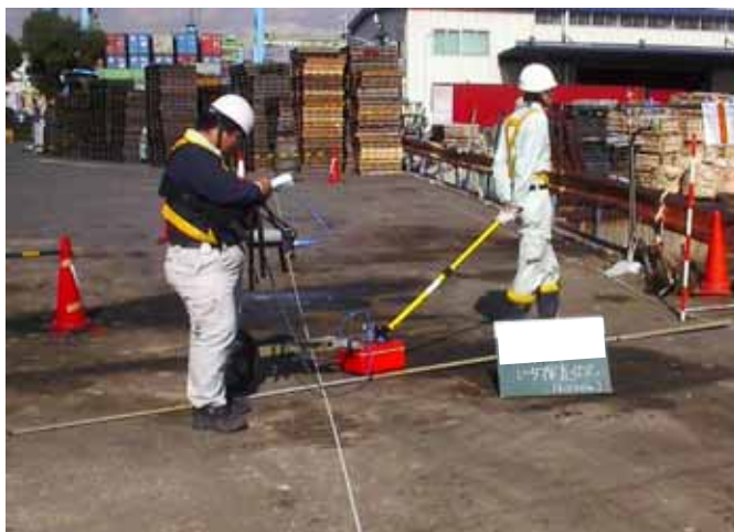
現場データ取得状況
